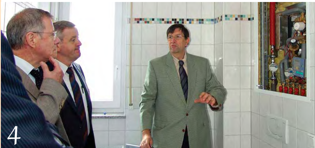
Zusammen mit Lothar Döhler erläutert Bautechniker Norbert Schnorr Winfried Hartmann vom Hessischen Ministerium für Wirtschaft, Verkehr und Landesentwicklung die Heizungs- und Installationstechnik.
