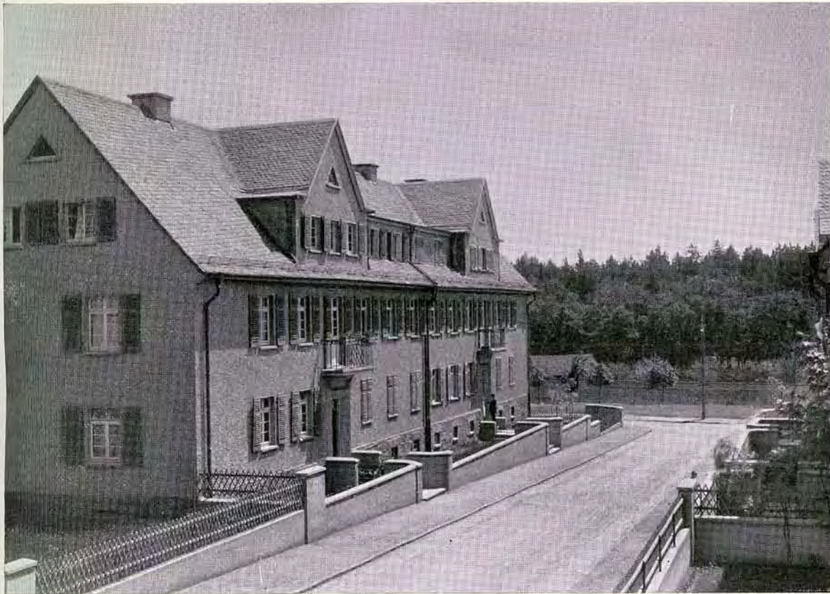
8-Familien-Doppelhaus der Miethäusergruppe in der „Friedensstraße“
