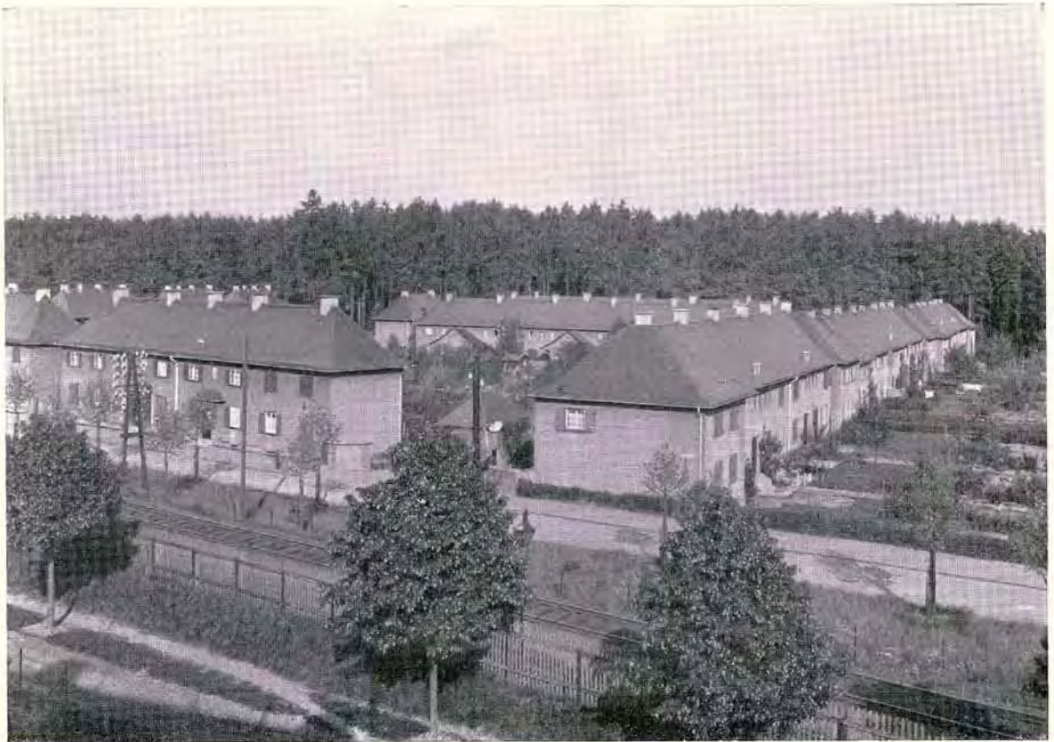
54 Einfamilien-Reihenhäuser zwischen Licherstraße und Fuldaer Eisenbahnlinie
