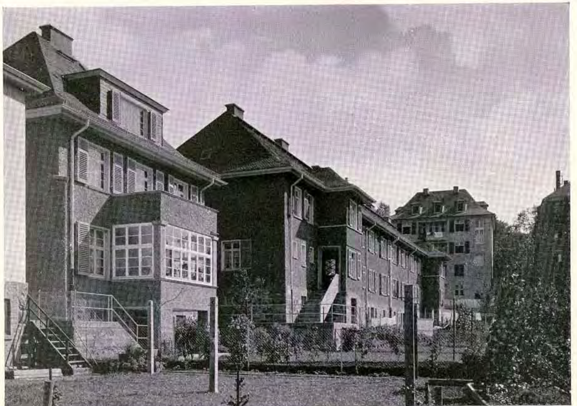
Gartenansicht der Einfamilienhäuser in der „Karl-Vogt-Straße“ (westliche Straßenseite)
